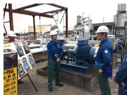
現場視察の様子
