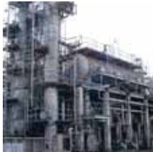
硫黄回収排煙脱硫装置
