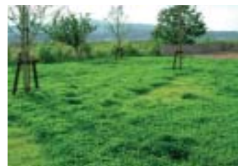
旧船川製油所埋戻し工事完了後
