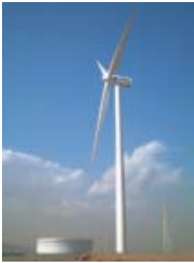
風力発電設備 2005年3月、鹿島製油所において開始しました。 ジャパンエナジーグループで2基目となります。
