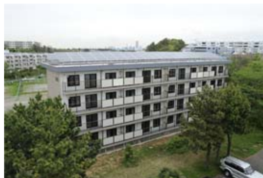
夕見台社宅における「創エネ+リノベーション」の実証実験
