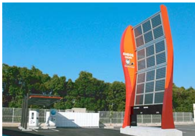
DDエネルギーモール八幡東田SSのソーラーパネルと急速充電設備
