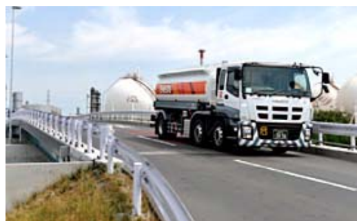
タンクローリーが住宅地を通らずに製油所に入出力できるよう、西地区と東地区の間に橋を設置
