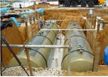
タンク入替工事イメージ
