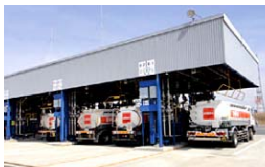
わずか2週間で完成した仮設出荷設備。
