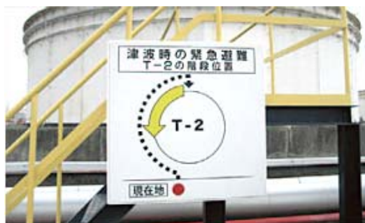
津波の襲来時に迅速に避難できるよう、階段の位置を示す看板を設置
