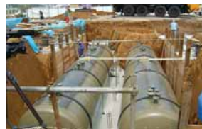
二重殻タンクへの更新工事
