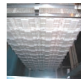
水蒸熱槽に設置された エコジュール®ゲルパック・モジュール
