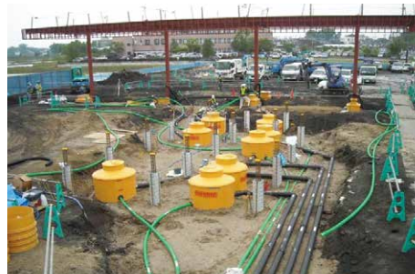
フレキシブル樹脂配管の敷設状況
