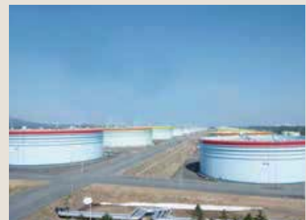
青森県むつ小川原の備蓄タンク群
