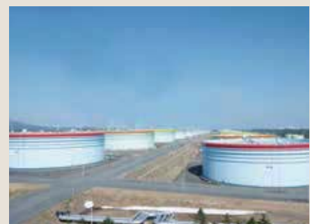
青森県むつ小川原の備蓄タンク群
