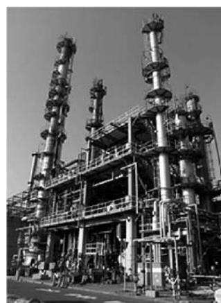
図3 新日本石油精製 (株) 根岸製油所 ETBE 製造装置
