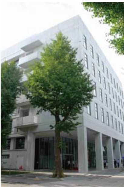
「ENEOSラボ」が入居した 「環境エネルギー研究棟」
