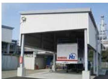
図2 水素製造出荷センター
