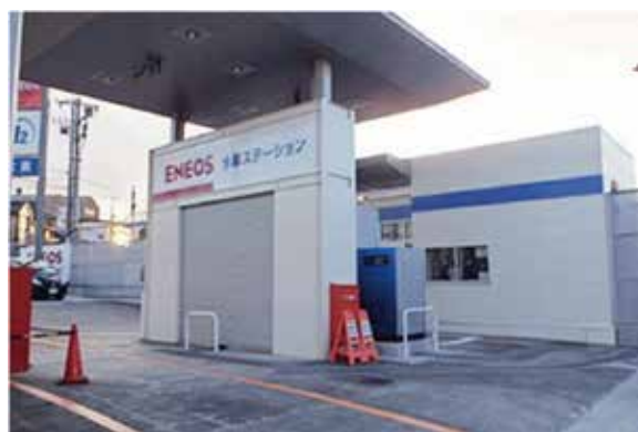
図4 横浜旭水素ステーション写真
