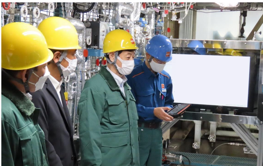
中央技術研究所構内における視察の様子
