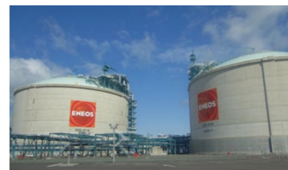
八户LNG总站。LNG储藏容量为28万kℓ。
