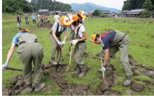
在湿地上用铁锹修建水路
