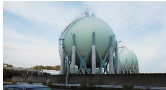
球罐支撑（支柱）加固
