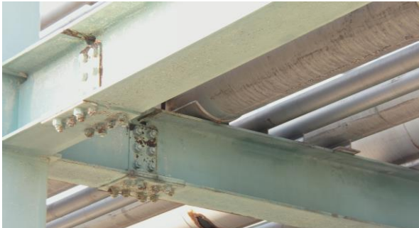
構造物の下側も点検可能
