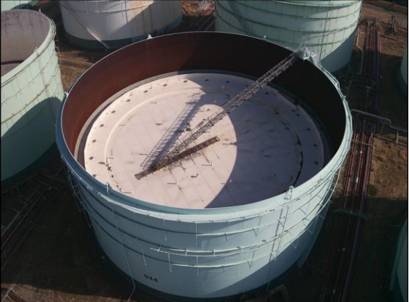
浮き屋根式タンクを上空から点検
