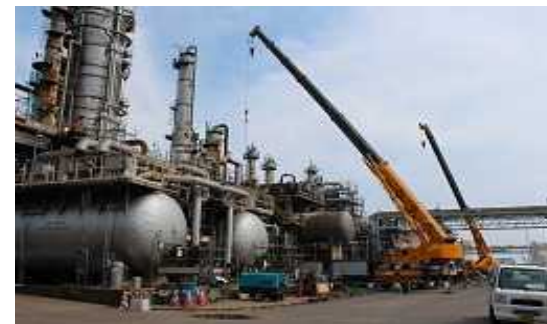
精製装置の点検・補修工事
