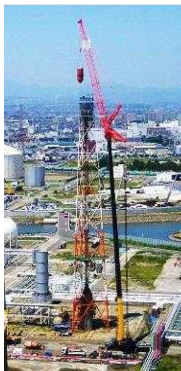
フレアスタック先端の機器の取替え工事
