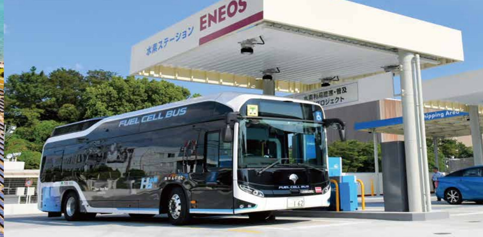
東京大井水素ステーション
