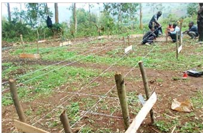
図書館の建設予定地を測量する
