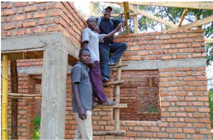
ポポフがアンガ中学校に建設している図書館
