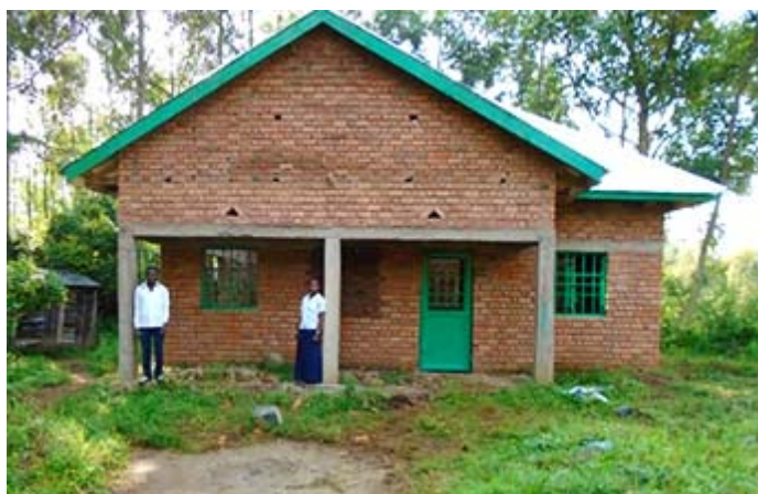
アンガ中学校に完成した図書館
