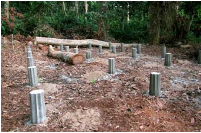
写真1:モンディカ・キャンプ地における先住民ガイド用のより大きな小屋の基礎部分©WCS Congo
