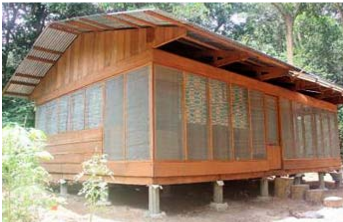
写真3:モンディカ・キャンプ地における先住民ガイド用の新しい建造物©WCS Congo
