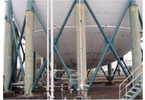
球形タンクのブレース補強例
