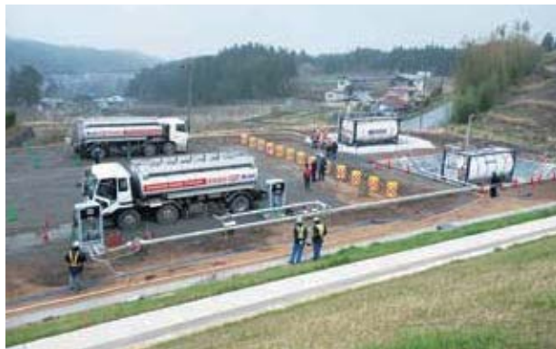
陸前高田市にコンテナ型仮設サービスステーションを設置
