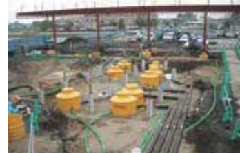
フレキシブル樹脂配管の敷設状況
