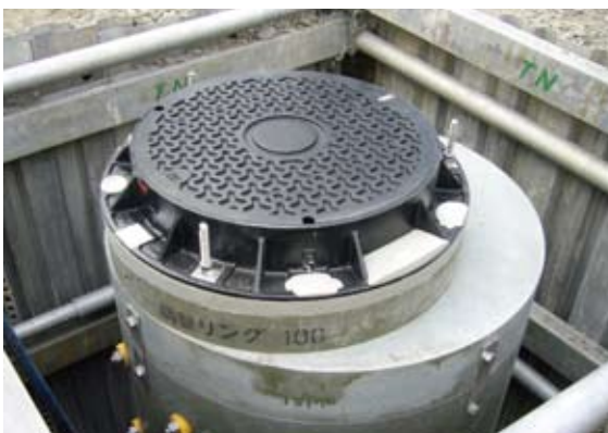
写真3 レコサールVホール設置の様子 (佐賀県武雄市)
