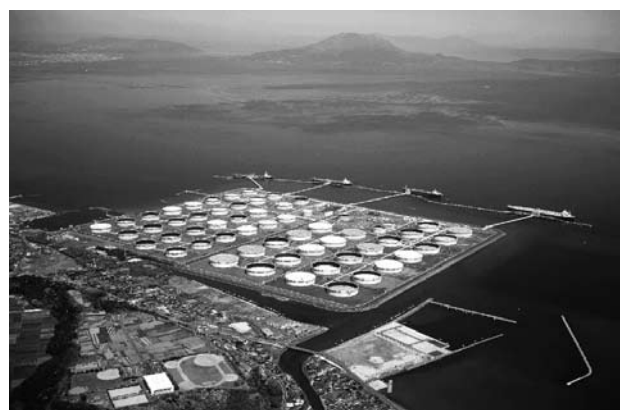
写真1 喜入基地の全景写真
