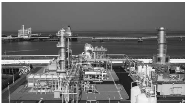
写真3 タンカー排出ガス処理設備全景
