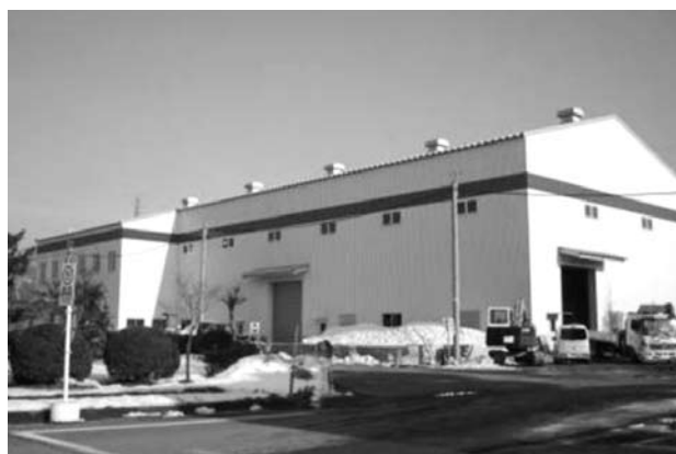
写真 2 廃電池のリサイクル工場
