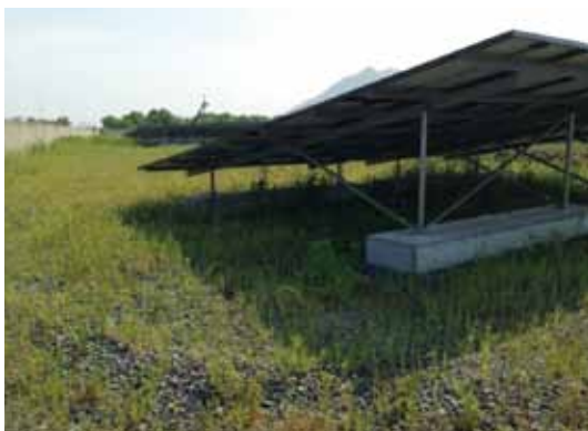
掘削せず設置可能な置き基礎工法
