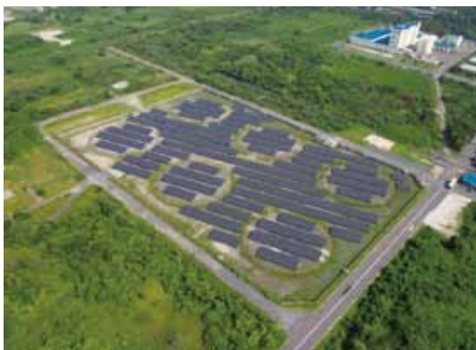
重油タンク跡地を利用した下松メガソーラー
