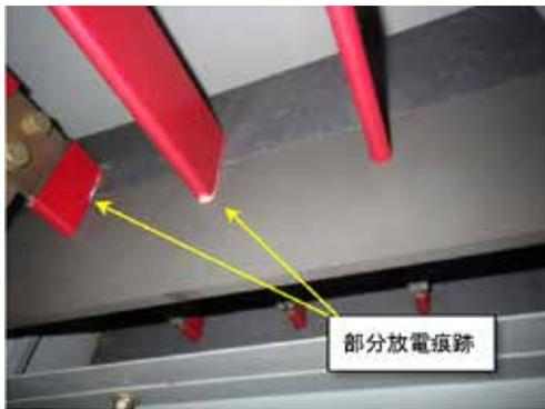
図7 実使用盤の部分放電痕跡
