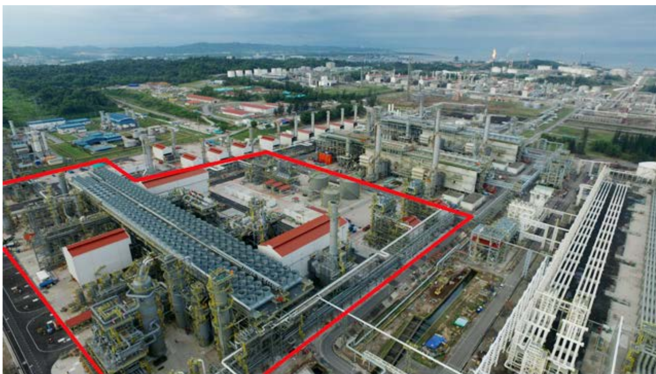
Aerial view of PETRONAS LNG Complex (Red Line shows Petronas LNG Train 9)
