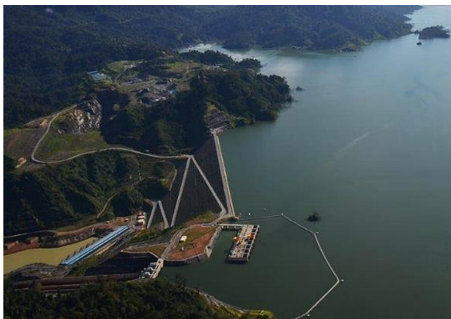
バクン水力発電所のダム
