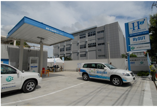
東京・杉並水素ステーション外観
