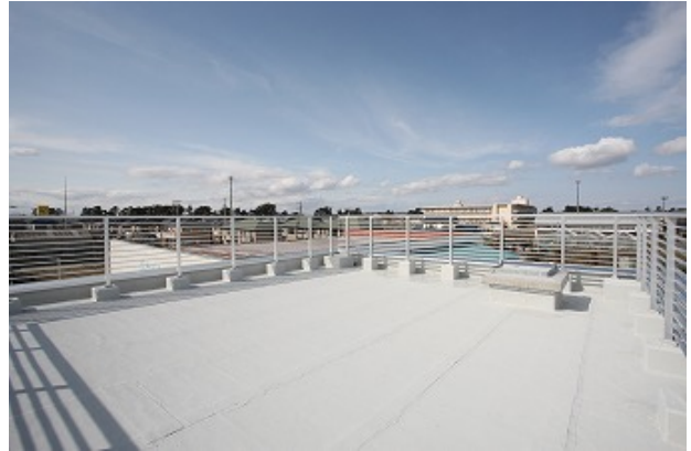
2階屋上スペース
