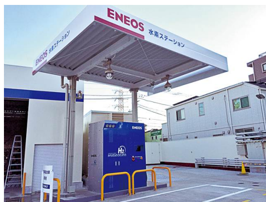
<水素充填機の設置状況>
