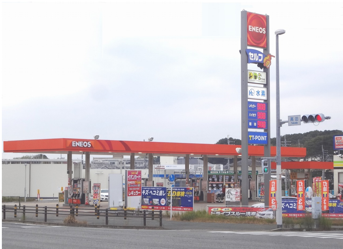
【水素ステーション】
