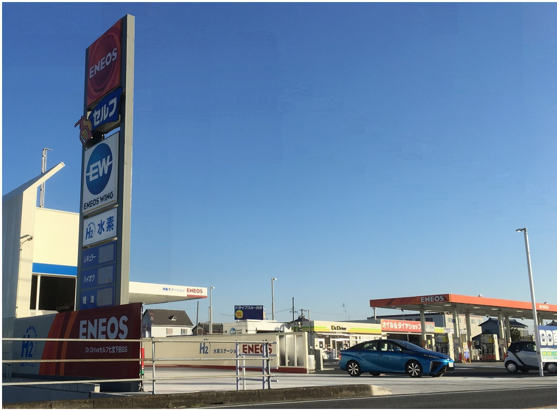
【水素ステーション】
