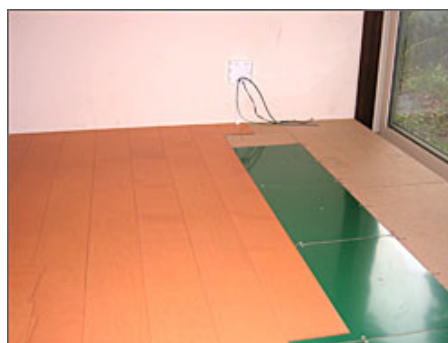
緑色のヒーターパネルの上に 床材(フローリング)を設置
