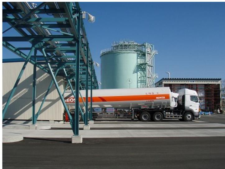
LNGタンクとLNGローリー積載ゲート
