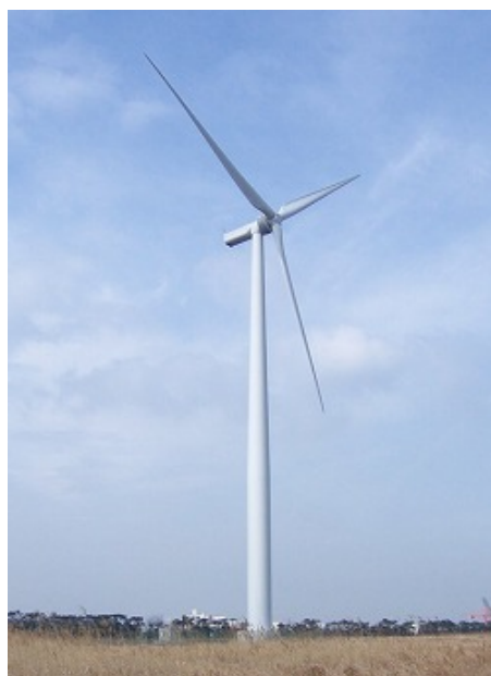
扇島風力発電所 発電設備
