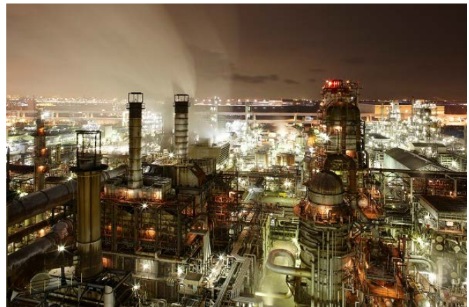
当社川崎工場は、石油精製および石油化学プラントが隣接し、効率的な一体運営を追求
