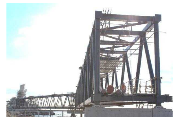
建設中の新設棧橋（左奥）と配管橋
