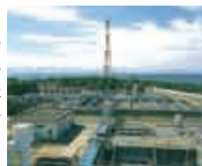
排水処理設備
