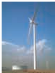
風力発電設備
