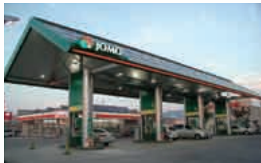
太陽光発電パネル設置サービスステーション
