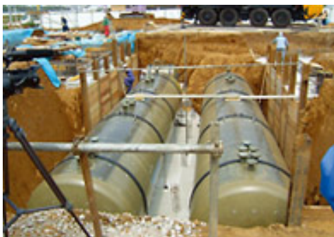
タンク入替工事イメージ
