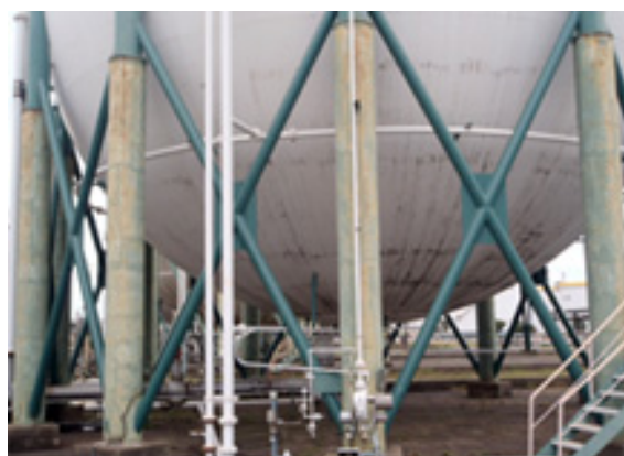
球形タンクのブレース補強例
