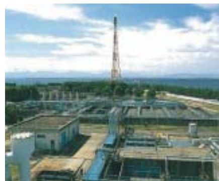
排水処理設備
