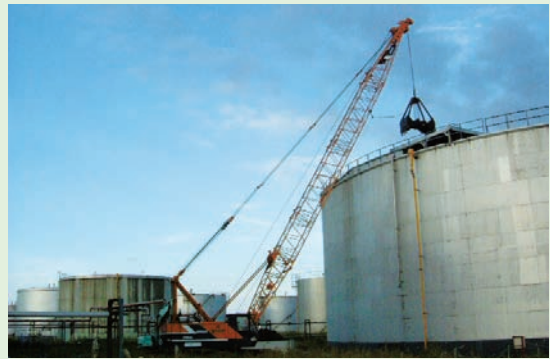
吊车吊出作业
