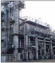
硫磺回收排烟脱硫装置
