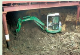
罐内堆积作业
