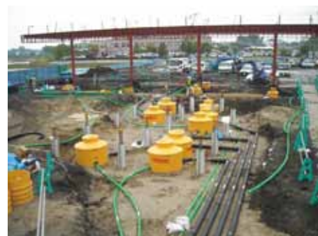
フレキシブル樹脂配管の敷設状況
