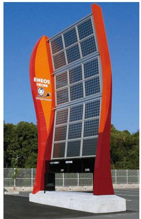
【太陽光発電出力】2.2kW(発電想定量:3kWクラス)
