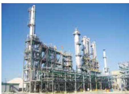
写真2 JX-NCTiのSAS製造装置全景
